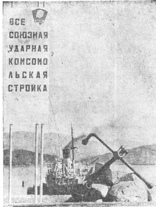
«Центральная площадь» нынешней стройки
